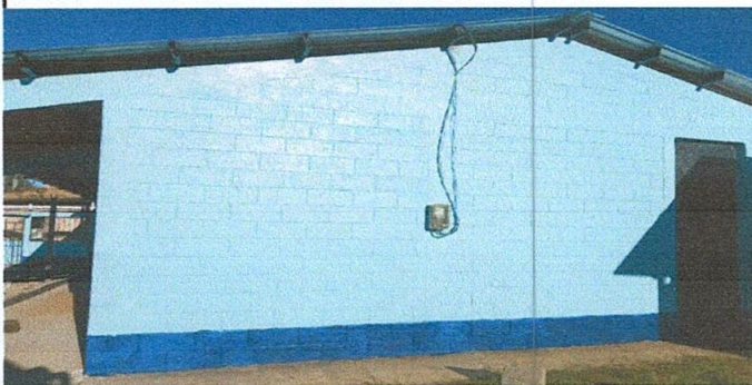
Foto 3: Mejoramiento de pintura en muros exteriores e interiores
