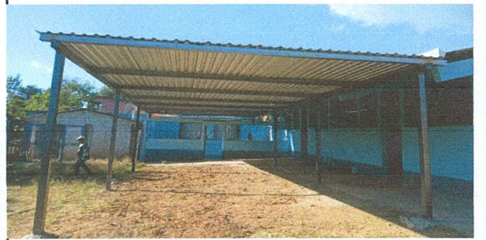
Foto 4: Sustitución de lámina por lámina troquelada y estructura de soporte de metal
