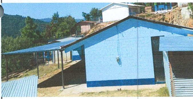
Foto 5: Trabajo de mejoramiento de edificios escolares públicos finalizado
